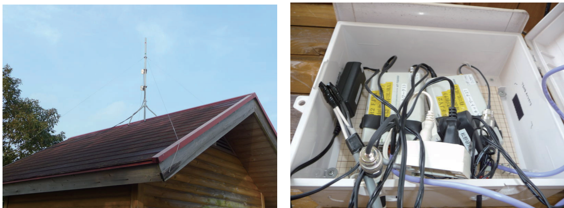
図 4.3 藤尾山における無線機の設置状況
