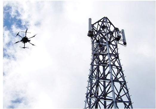
図1 ドローンによる携帯電話基地局点検
