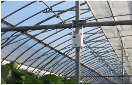
(a) 地域就農者ハウス内に設置されたエンドデバイス
