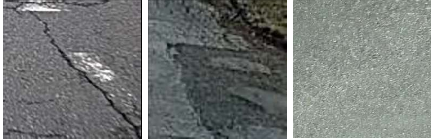
(a) クラック (b) ポットホール (c) 舗装面
