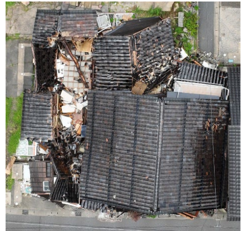
図 11 損傷あり(1)と判定された家屋の屋根形状データ（左）と空撮画像（右）
